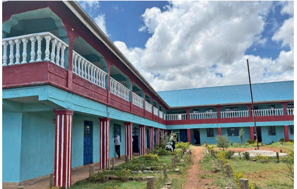
Die fertiggestellte Elementary School
